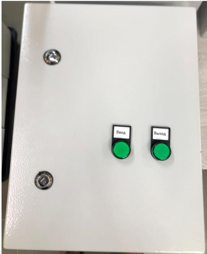
Рисунок 1.5 - Расположение световых индикаторов
